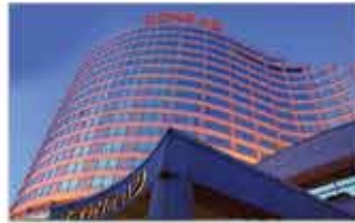
AKSOY İNŞAAT - CONRAD OTEL
