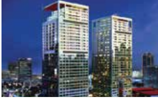
BAY İNŞAAT - MASLAK 42
