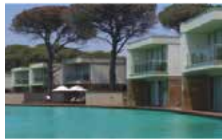
SEMBOL İNŞAAT - RİXOS BELEK
